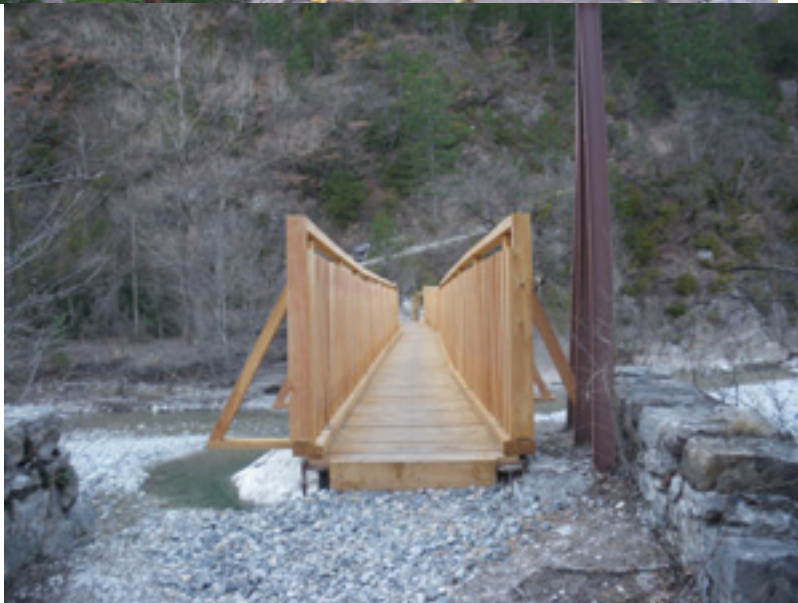
Passerelle du Creisset avant et après travaux - Images cliquables
